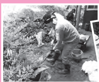
裏庭に流れ込んだ泥の除去
