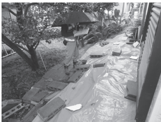
被災宅現地調査の様子
